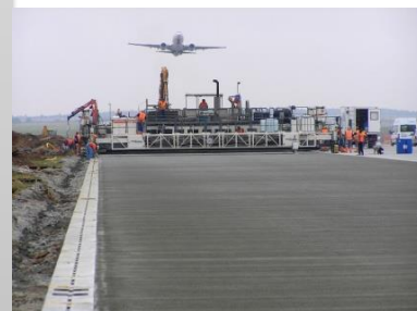
Pokládka betonového krytu pojezdové dráhy
